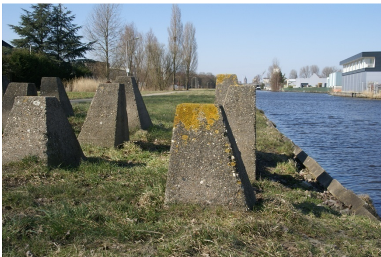
Afb. 3.2 Duitse drakentanden antitankversperring langs de Schie bij Delft-Zuid (foto A. Bosman, Military Legacy).
