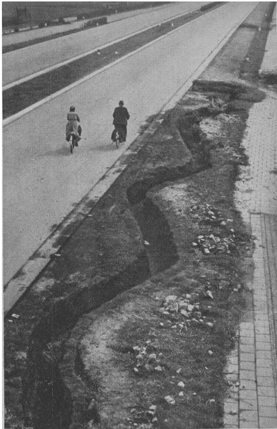
Afb. 9.1 Een schuilloopgraaf langs de voormalige Rijksweg bij Delft in 1945 (collectie Bosman, Military Legacy).
