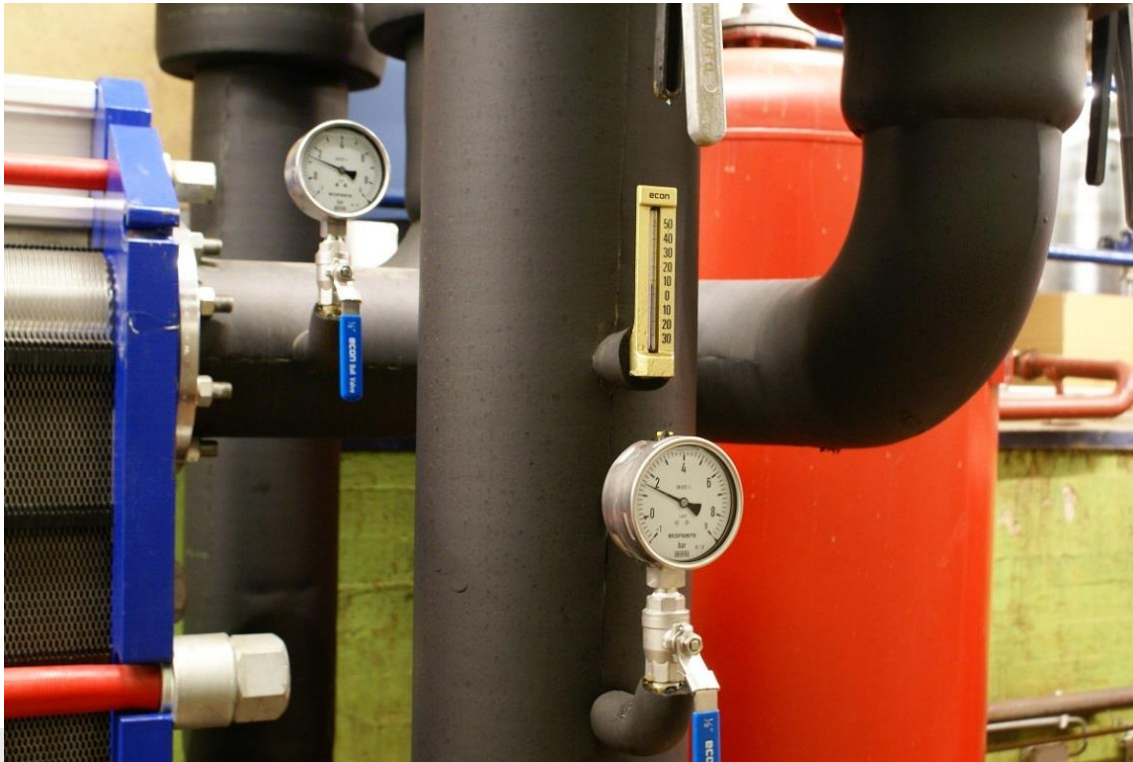
Meetinstrumenten: indicatoren voor druk en temperatuur.
